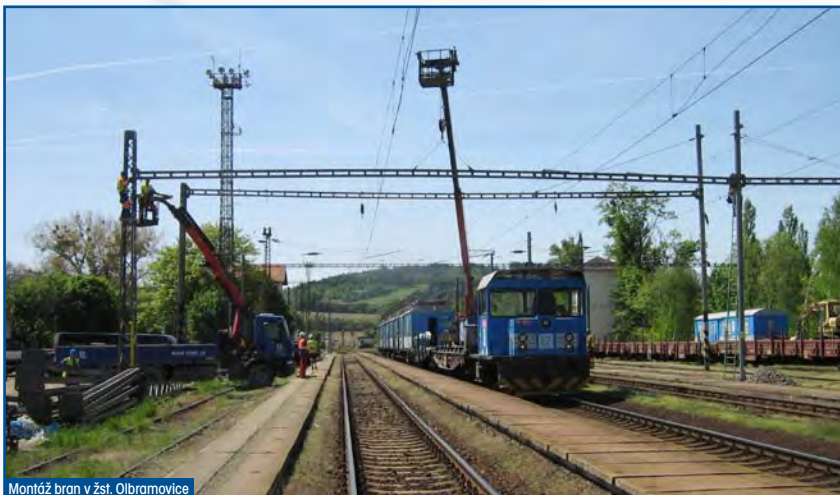
Montáž bran v žst. Olbramovice
