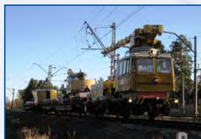
Pracovní vlak vyjíždí ze žst. Klooga rozvázet prefabrikované základy. Foto: Jiří Vozáb
