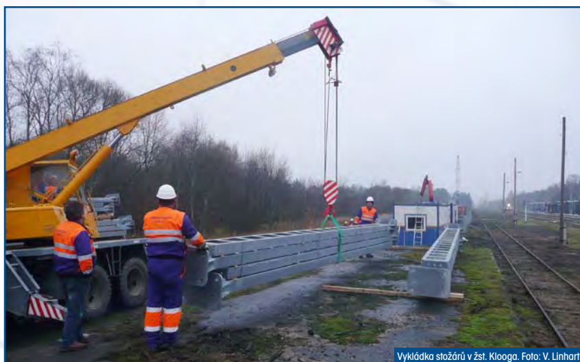
Vykládka stožárů v žst. Klooga. Foto: V. Linhart
