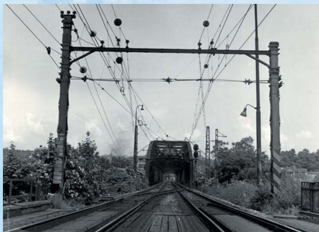
Původní trakční vedení na železničním mostě přes Vlavu, pohled od Smíchova
