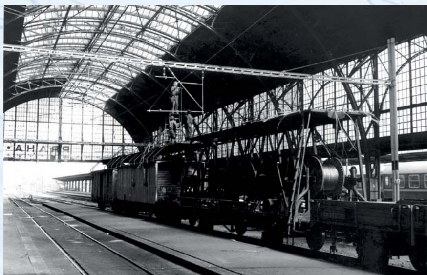
Rekonstrukce trakčního vedení v žst. Praha hl.n. v roce 1976
