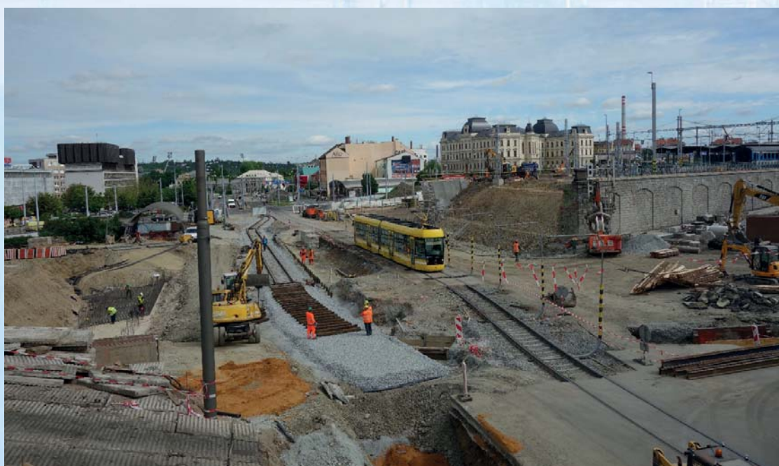
Obr. 2: Pohled na staveniště po demontáži severního mostu. Tramvajové vedení uchyceno na příložkových stožárech.
