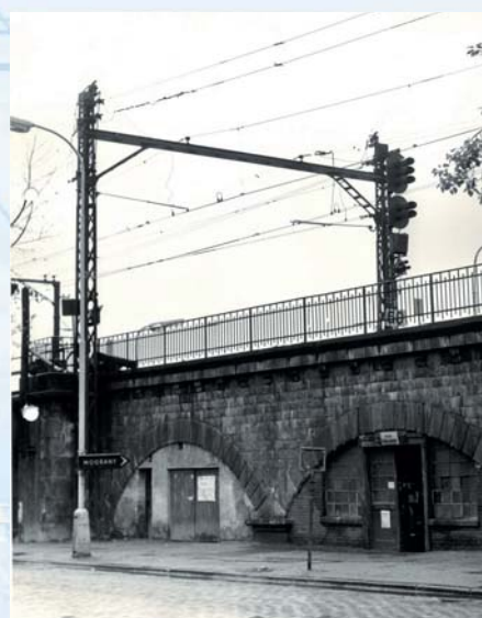
Původní trakční vedení na železničním mostě na Výtčoni
