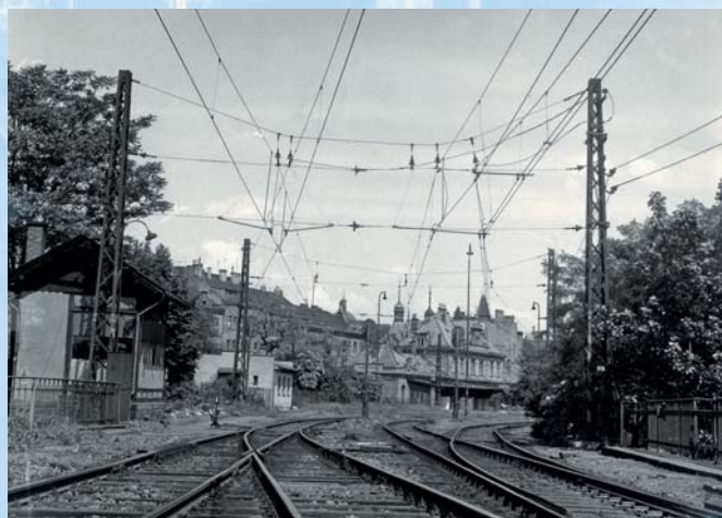
Původní trakční vedení v žst. Praha Vyšehrad
