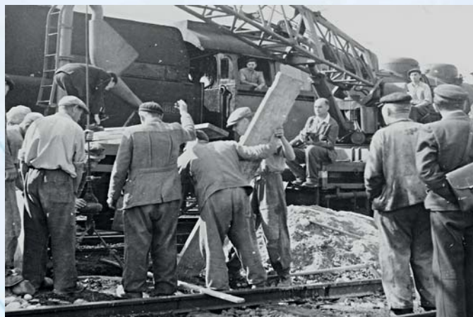
Montáž základu trakčního vedení
