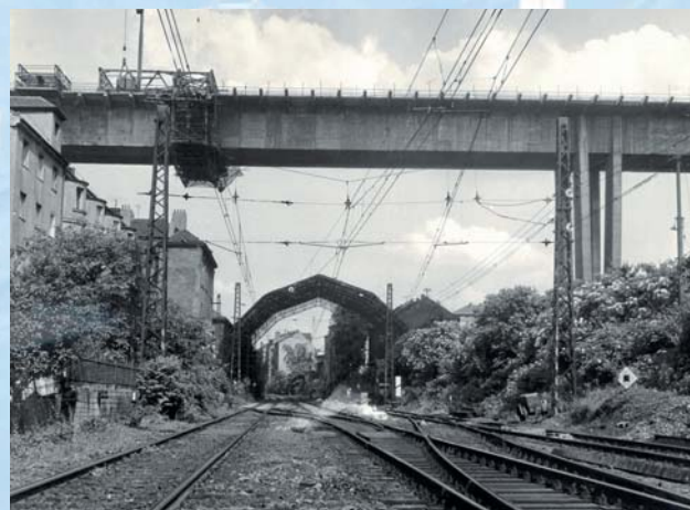
Ochrana trakčního vedení při výstavbě Nuselského mostu.
