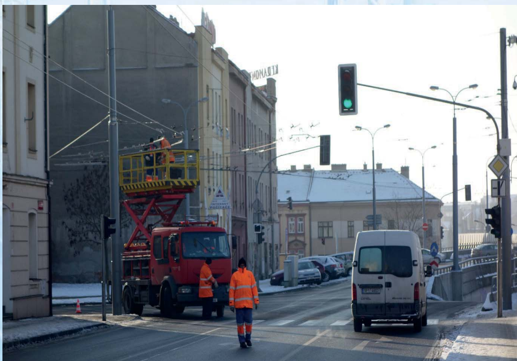
Montáž trolejbusového vedení na křižovatce ulic Koterovská a Železniční
