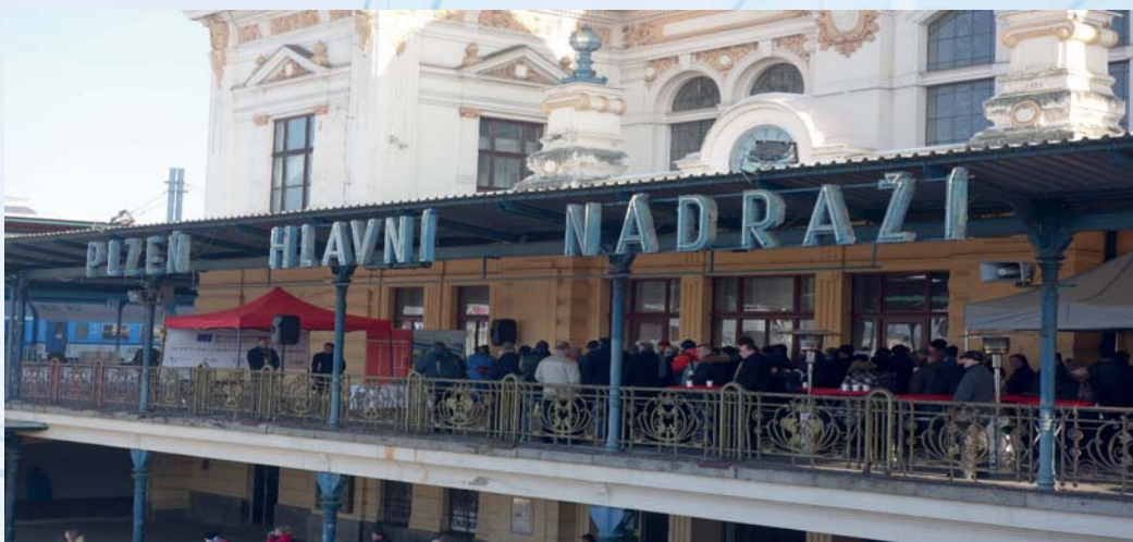
Slavnostní zahájení stavby na Plzeňském hlavním nádraží
