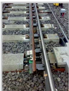
Obr.4: Topná tyč opornice
