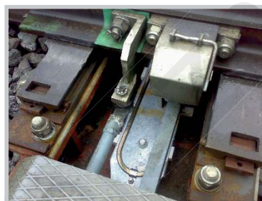
Obr.5: Topná tyč závěru žlb pražec
